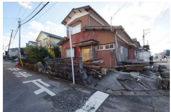
(出展:日経クロステック)
