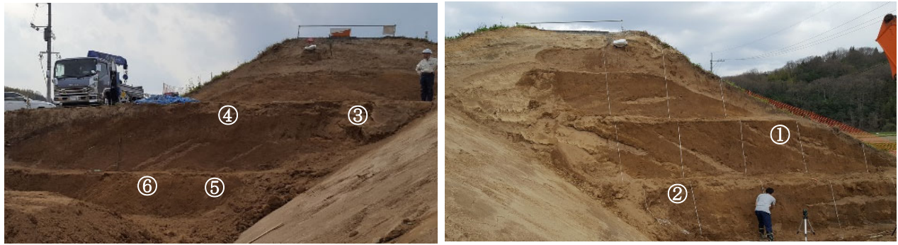
図1 左岸 6.4k の破堤箇所における開削調査時の現場透水試験の実施箇所（左：下流断面，右：上流断面）
