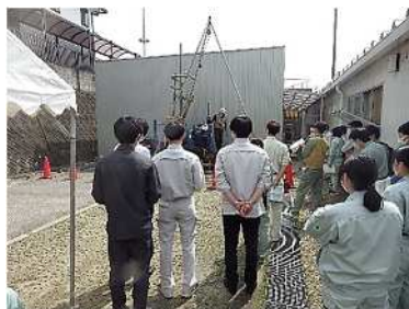
(ボーリング作業)
