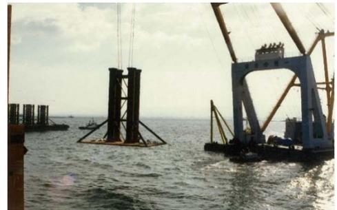
写真-1CB 沈下板の設置状況(1)
