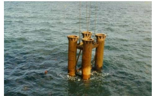
写真-2 CB 沈下板の設置状況(2)
