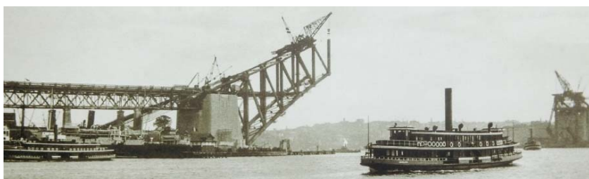
建設中の北側橋台。アーチをケーブルで引張、アーチ上をクレーンが移動 （この写真は、現地の橋台に、パネル掲示されています）
