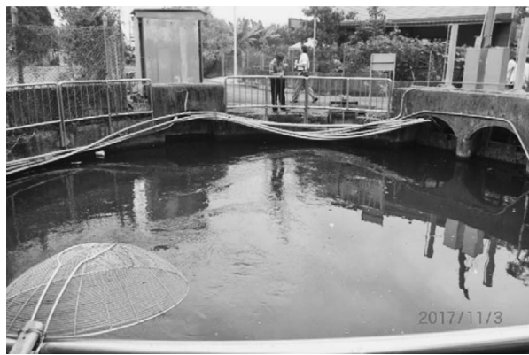
写真－6 当時のまま稼働中の円堀も見学
