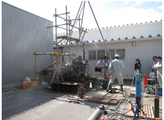
(ボーリングマシンの全景+孔内水平載荷試験) (内容:ボーリング, 標準貫入試験, サンプルの解説)
