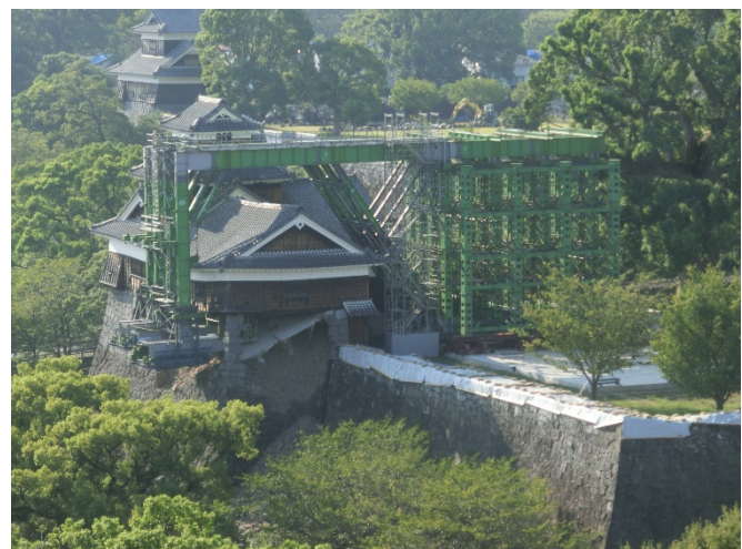
(番外編：熊本市役所からみた熊本城飯田丸五階櫓の修理)
