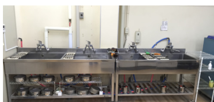
(物理試験室の給湯器の新設)
