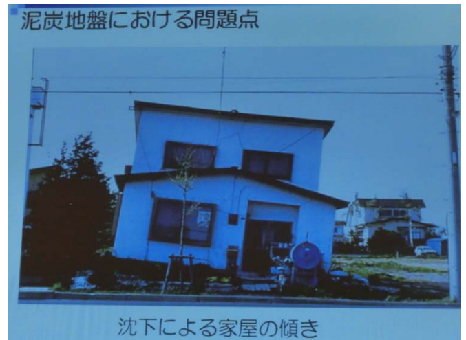
p-5 泥炭地盤における問題点(家屋の傾斜)
