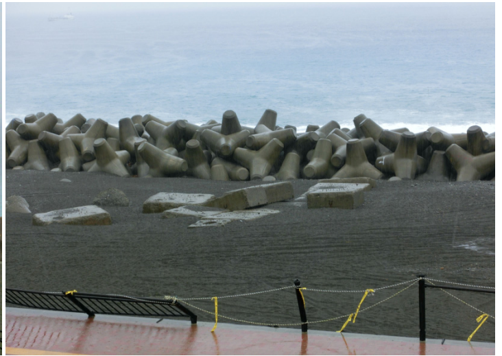
写真-1.11 テトラも波浪で移動(H23年9月の台風15号)すること (防波堤を越えて移動). 波浪の力も凄いですね
