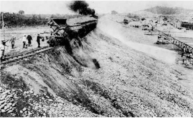
写真-3.2 堰堤の下流側盛土・射水作業状況 (講演資料より)
