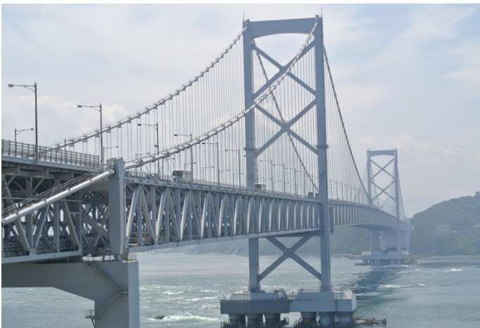
p-5 淡路側からみた大鳴門橋
