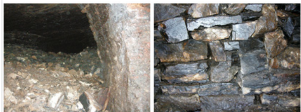
p-9 一部埋積されている坑道 p-10 整然と積まれている側壁
