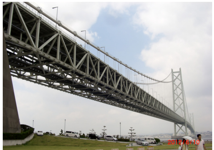
p-11 雄大な明石海峡大橋を淡路島側から眺める。対岸は、神戸市。
