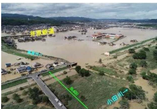
岡山県真備町の浸水被害(小高教授の第18回技術講習会資料)
