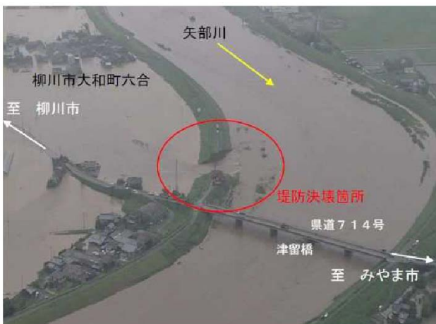
平成 24 年九州北部豪雨矢部川堤防の破堤 (九州地整 HP)
