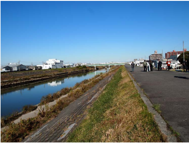
p-4 見学会当日の復旧された破堤ヶ所
