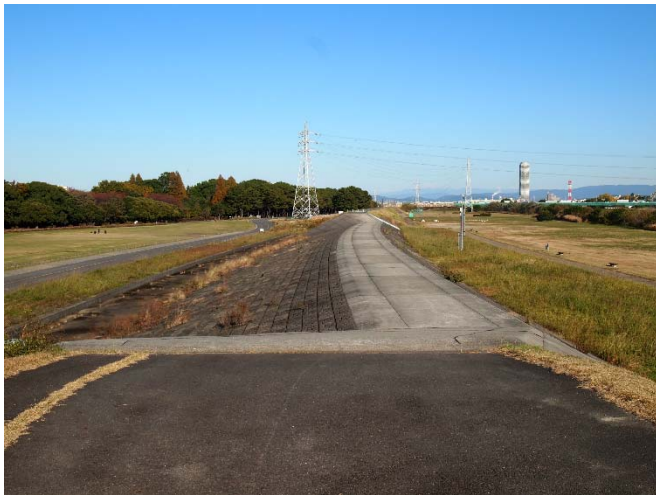
p-8 小田井遊水池の越流堤見学(一段低いヶ所)
