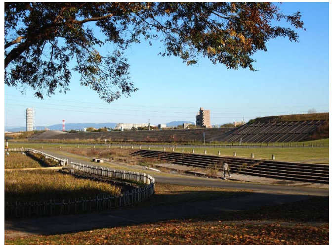
p-9 越流堤を内水地側から見る(低い状況を把握できる)
