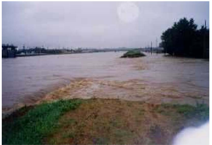
p-5 平成12年東海豪雨時の破堤状況
