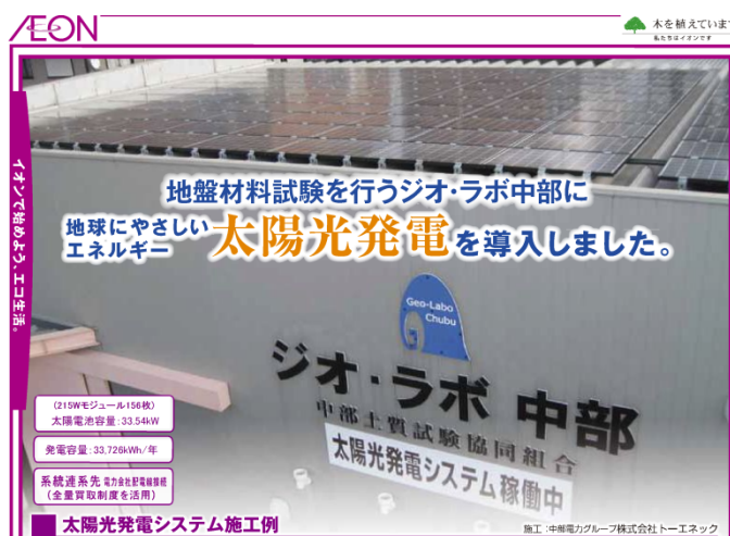
図-3.2 事務所屋根に設置 (正面壁面に発電パネル設置)
