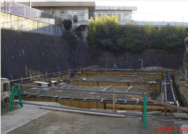
(平成25年1月28日(月)現在での施工状況)
