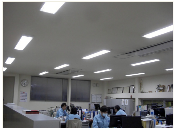
(2F 事務所部分の LED 化完成状況)
