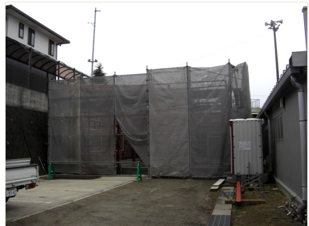
(2月19日(火)現在での施工状況)
